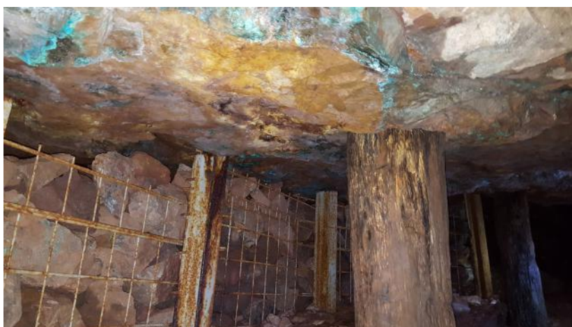
Galerie des mines de cuivre du Thillot dans les Vosges – Photographie DDT88
