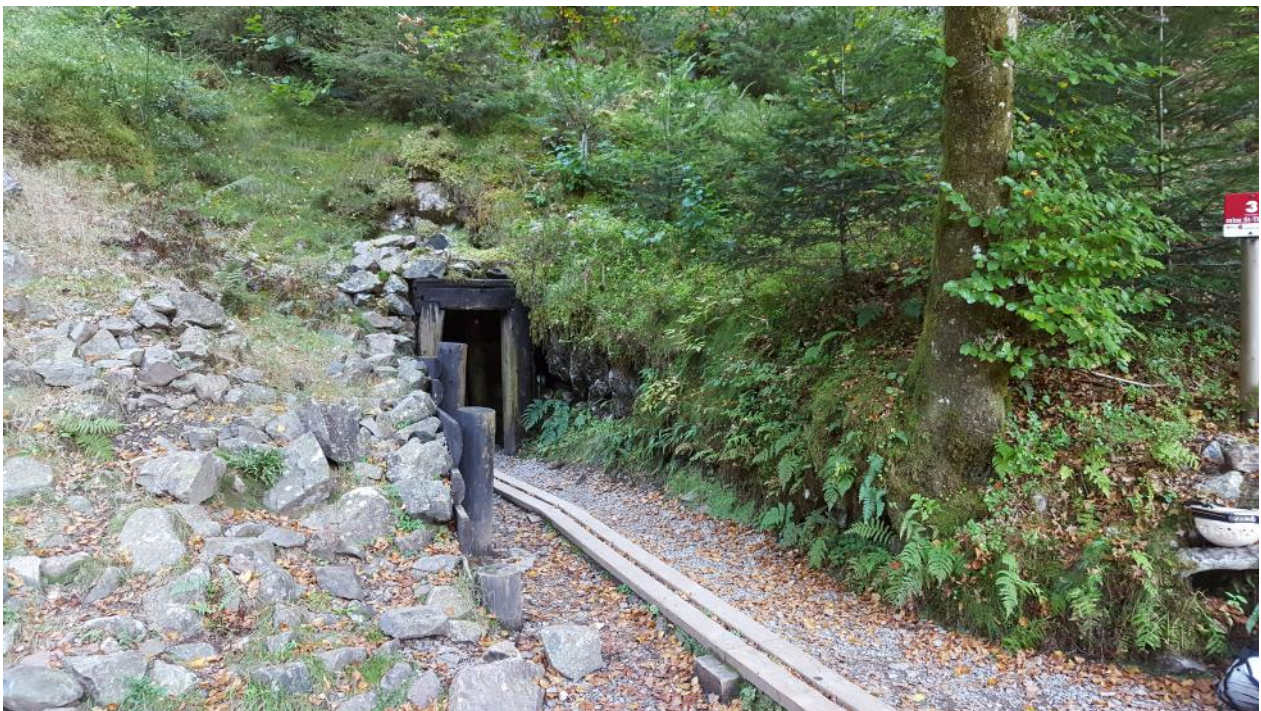
Entrée de la galerie des mines de cuivre du Thillot dans les Vosges – Photographie DDT88
